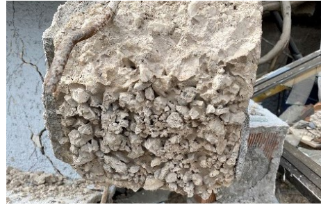
15b: beton kalitesi
