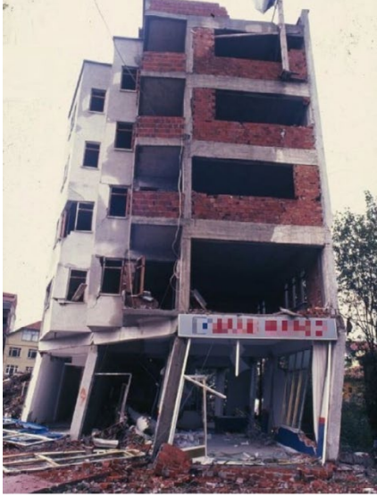
Şekil 6: Deprem Saha Bölgelerinden Yumuşak Kat Düzensizliği Sonucu Zemin Katta Büyük Göreli Kat Ötelenmesi Yapmış Bina Örnekleri
