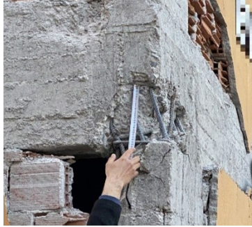
Şekil 13: Kolon Kiriş Birleşim Bölgesi Etriye Aralığı Ölçümü Özalper Mahallesi, Yeşilyurt, Malatya 38,34101111 K; 38,28207778
