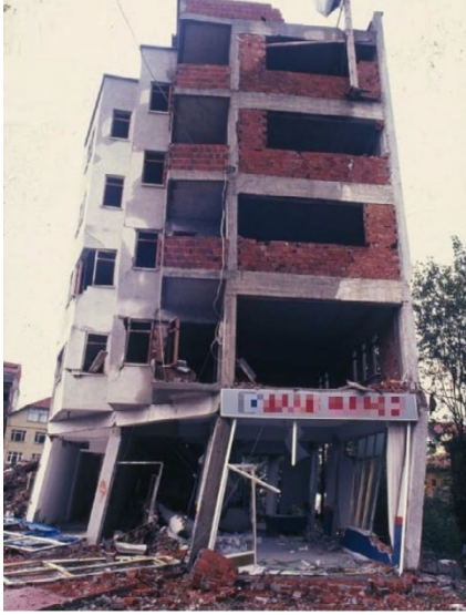
Şekil 6: Deprem Saha Bölgelerinden Yumuşak Kat Düzensizliği Sonucu Zemin Katta Büyük Göreli Kat Ötelenmesi Yapmış Bina Örnekleri
