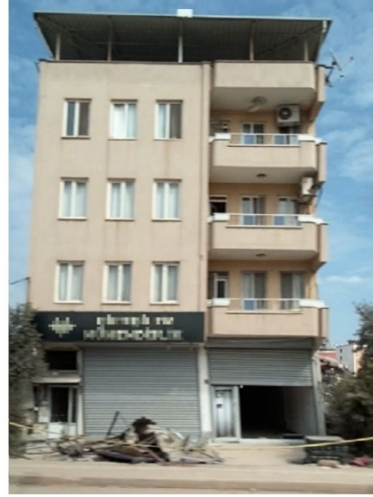
Şekil 6: Deprem Saha Bölgelerinden Yumuşak Kat Düzensizliği Sonucu Zemin Katta Büyük Göreli Kat Ötelenmesi Yapmış Bina Örnekleri
