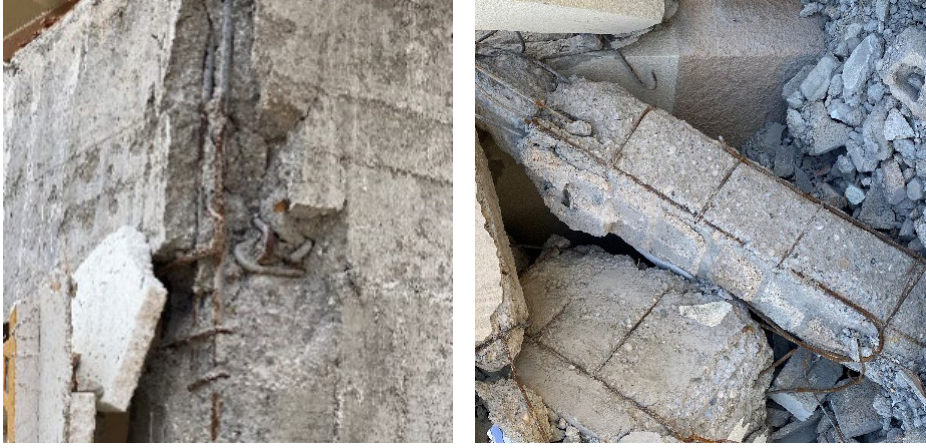
Şekil 11: Yüksek Etriye Aralığı ve Birleşim Bölgesi Sargı Donatısı Eksikliği
