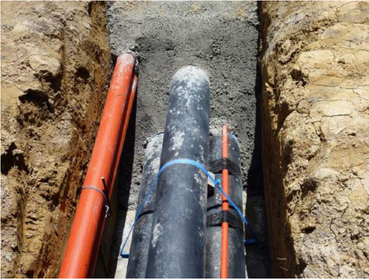
Fotoğraf 17: Havaî Hatların Yer Altına Alınması İşlemi 139
